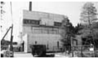
新施設建設が急務(いずみ清掃工場)
