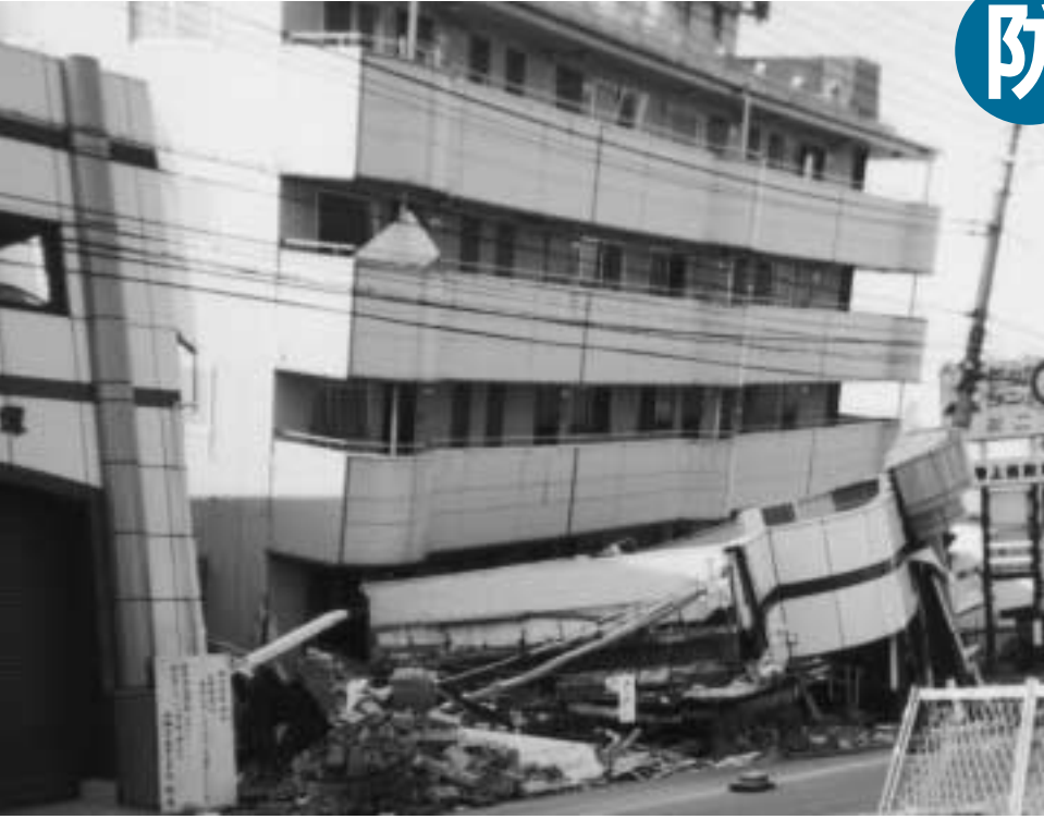
一瞬のうちに1・2階がつぶれたビル（阪神・淡路大震災）
