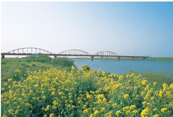
利根川堤防からの眺め
