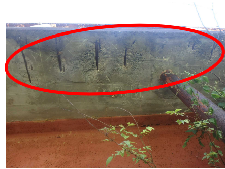
主な損傷(床版の鉄筋露出)
