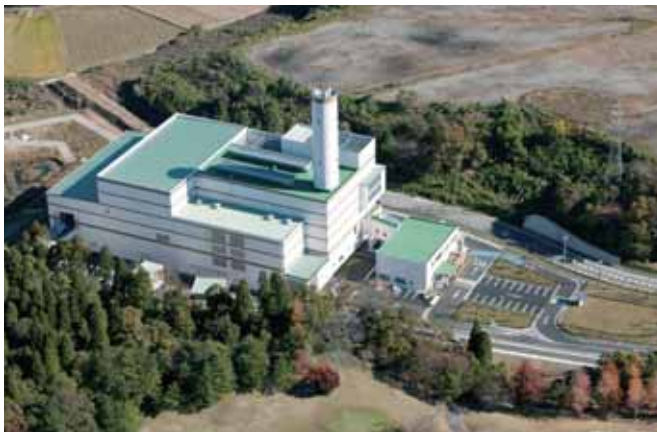
富里市と共同で建設された成田富里いずみ清掃工場
