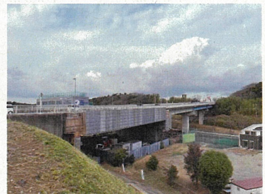
R6.2.20 現在 郷部大橋（全景）
