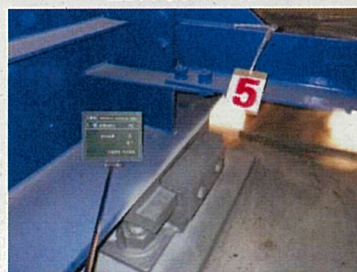
金属溶射後（支承）
