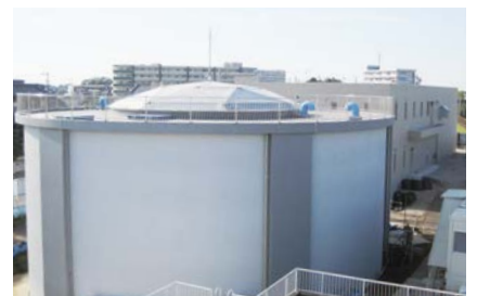
改修中の並木町配水場
