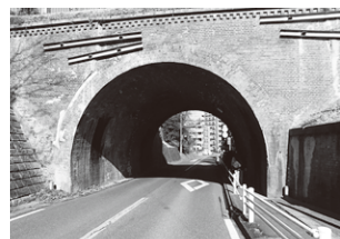
①成宗電車第一トンネル
