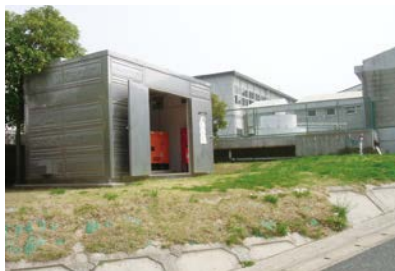
本市で設置している防災井戸
