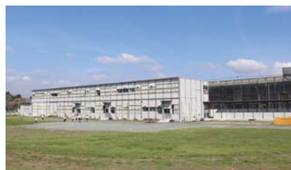
改修中の八生小学校・児童ホーム
