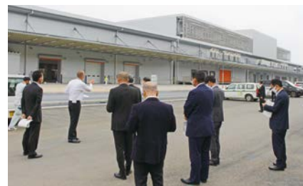
新生成田市場の建設現場を視察
