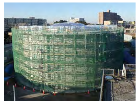
改修中の並木町配水場
