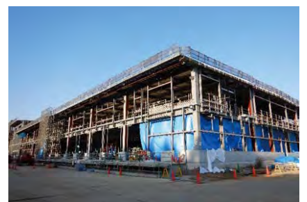
建設工事中の新市場
