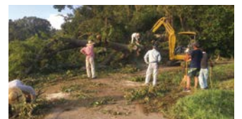
倒木の撤去作業をする住民(長田区)
