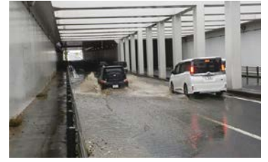
冠水した不動トンネル付近
