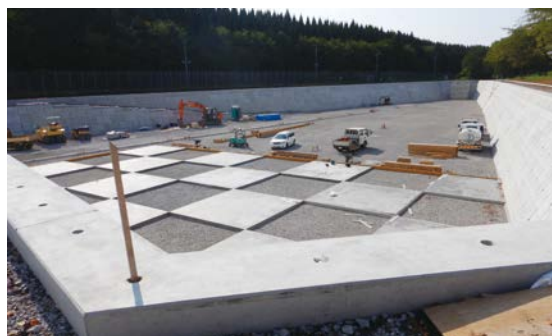
調整池築造工事
