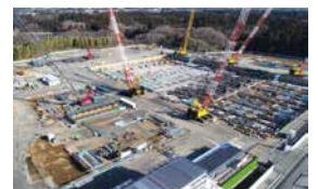
大学病院の建設現場
