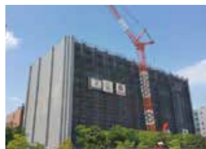
建設工事中の医学部校舎
