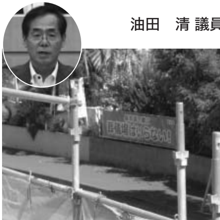
▲葬祭場が建設される赤坂地区付近
