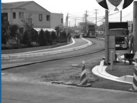
▲工事が進む西三里塚大清水線
