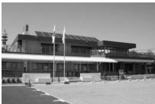
▲大規模改修工事が行われた橋賀台保育園
