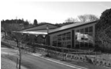
▲建設中のさくらの山観光物産館
