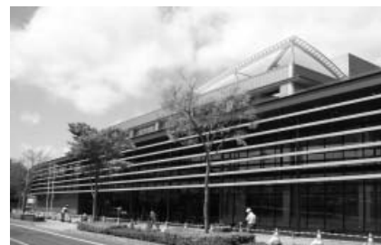
▲7月1日に開館する公津の杜複合施設
