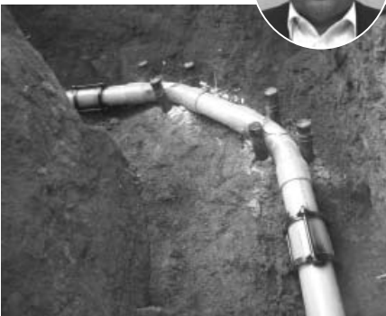
▲老朽化した土地改良区の用水管の補修工事
