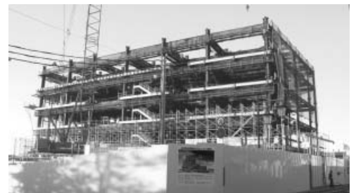
▲工事が進められているJR成田駅東口再開発ビル
