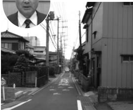
▲市内の狭隘道路
