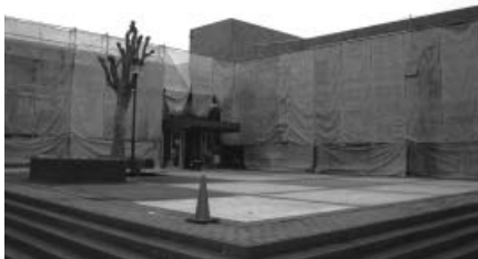
▲3月まで屋根・外壁改修工事を行った中央公民館
