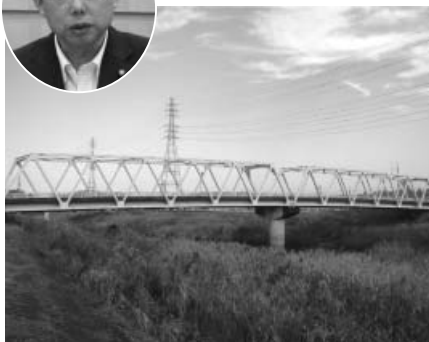
▲20年後に建設後50年以上となる開戸橋
