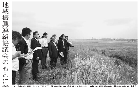
▲防音堤より平行滑走路を望む(協力:成田国際空港株式会社)
