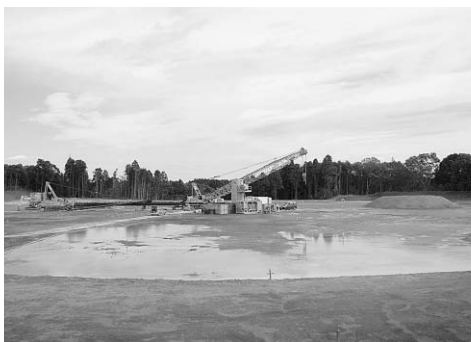
▲建設中の(仮称)大栄野球場
