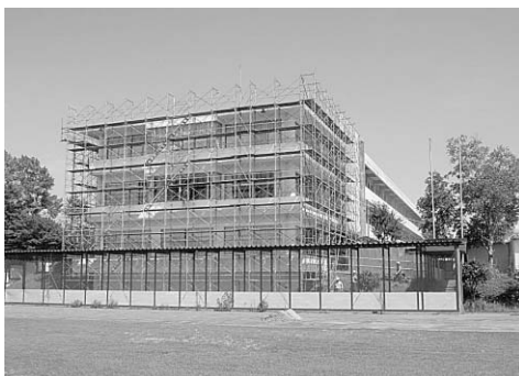
▲耐震補強・大規模改造建築工事中の下総中学校
