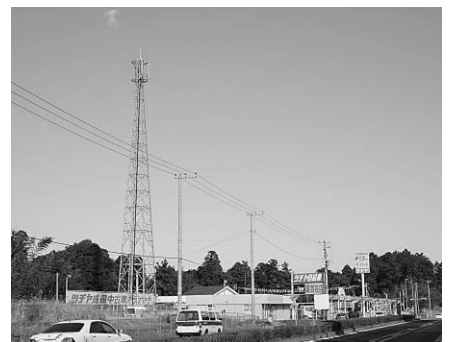
▲不動ヶ岡の電気通信事業用無線鉄塔
