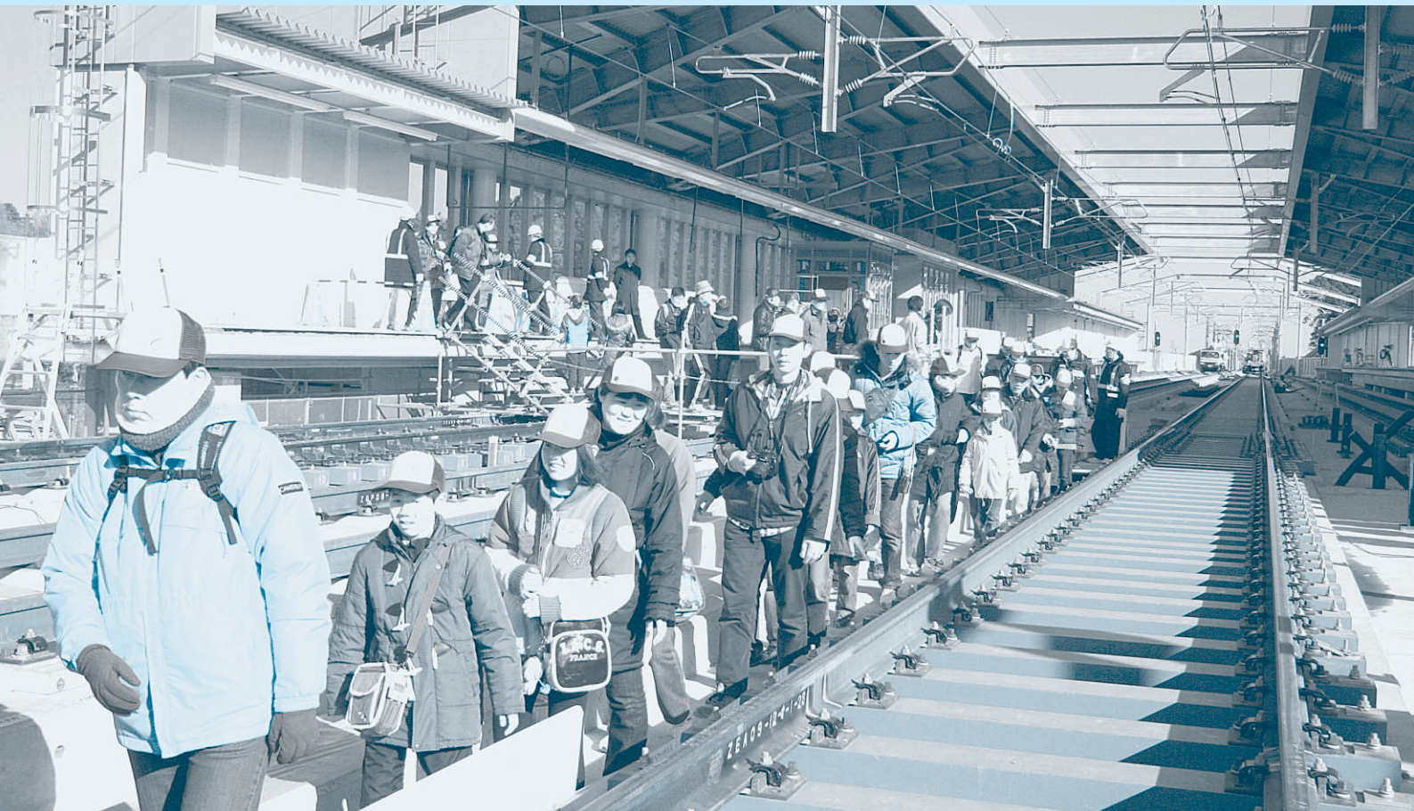
▲平成22年7月の開業を目指して工事が進められている「成田新高速鉄道」。開業前のイベントとしてレールウォークが開催されました。(1月17日 成田湯川駅)
