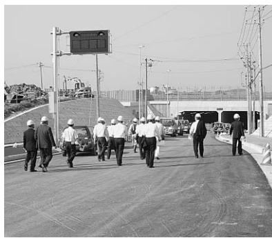
▲滑走路北伸に伴う国道51号切替工事現場
