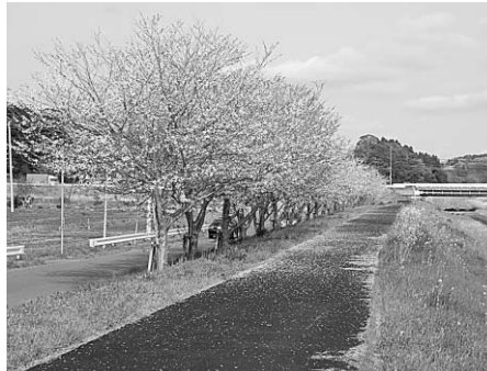
▲空港から市街地まで整備が進められる桜づつみ
