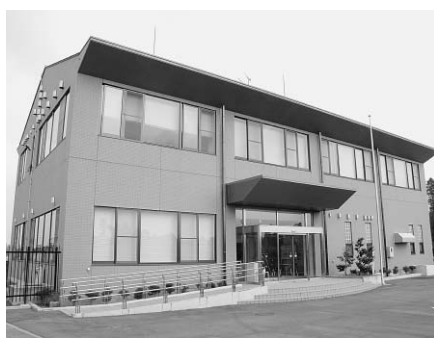
▲大栄地区の“伊能浄水場”
