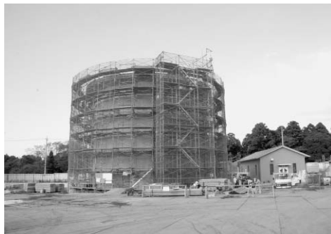
▲下総地区に建設中の“小野浄水場”
