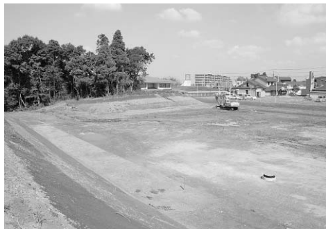
▲工事が始まった“(仮称)公津消防分署”
