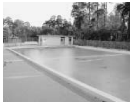
▲消防水利としても利用される学校のプール
