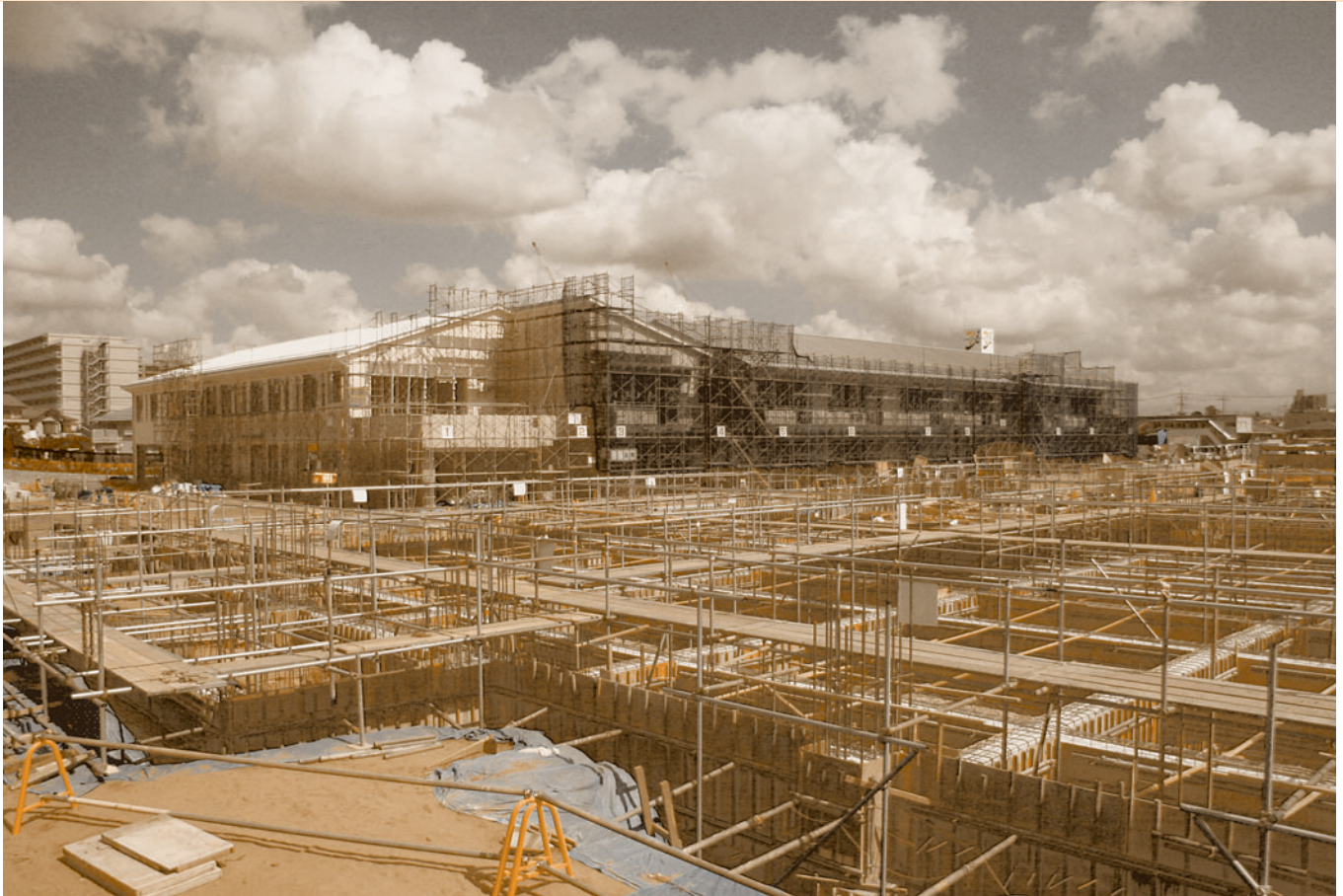
▲平成18年4月開校に向け建設の進む公津の杜小学校。手前は屋内運動場とプール。
