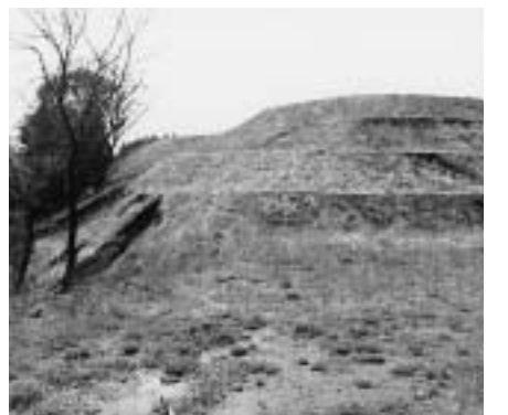
▲違法埋立てされた残土
